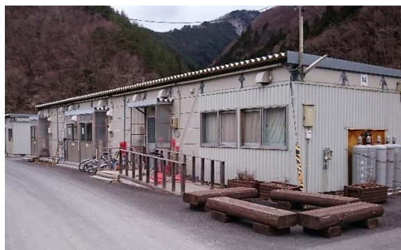
(簡易宿舍現況(釜石市))
