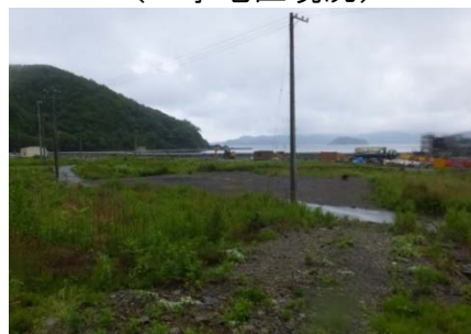
(工事地区現況)
