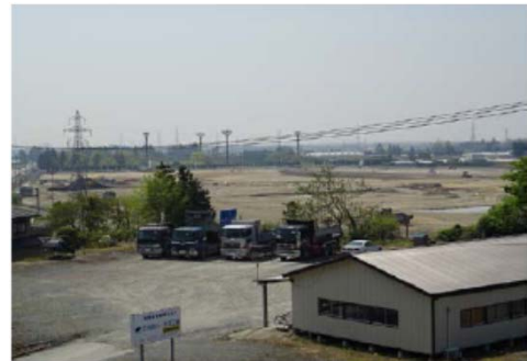
(造成工事の状況)
