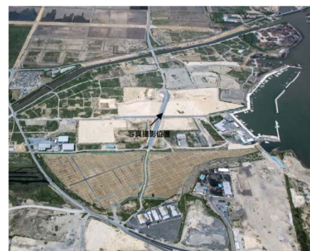
(工事地区現況)
